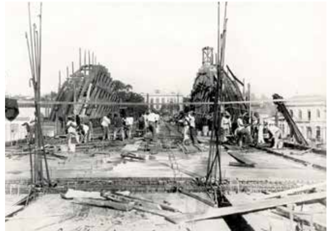
Construção do viaduto de Santa Tereza
