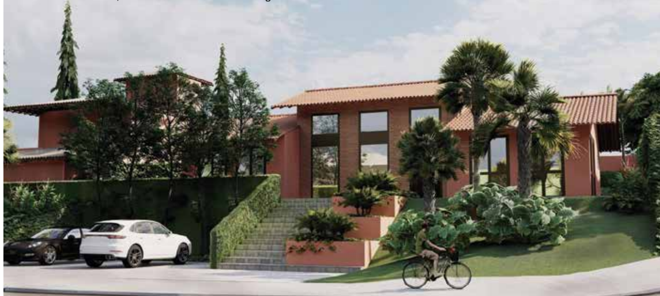
Casa projetada pelo escritório CLS Arquitetura em fase de construção em um condomínio em Lagoa Santa
