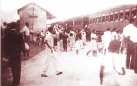
Estação Bernardo Monteiro
